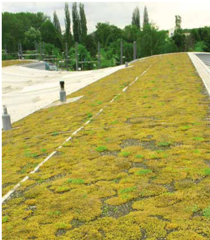
Curtea fabricii din Frankfurt Vegetație extensivă pe un acoperiș curbat
