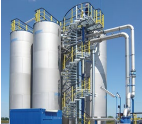
Quelle: DynaSand-Filter von Nordic Water
