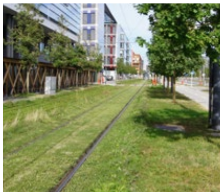
Anlage von Gleisbegrünung mit Gras
