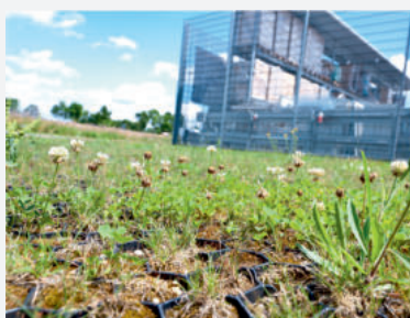
Bettungs-, Füll- und Decksubstrat. Die Wabe ist mit mind. 2 cm Substrat zu überdecken (Stand 2018)
